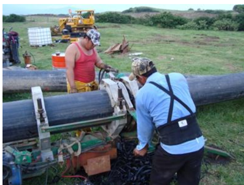
Figura 26. Armado de tubería de 12" de diámetro.
