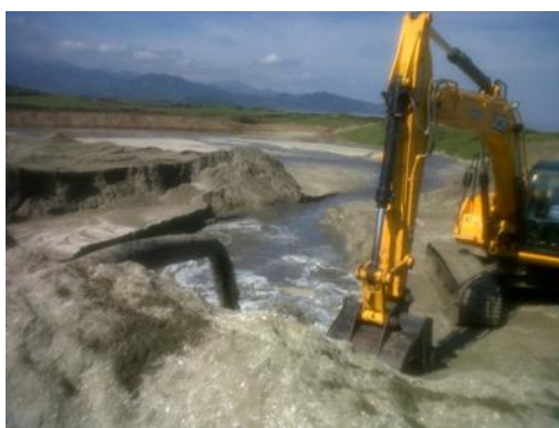
Figura 28. Construcción de tarquinas.
